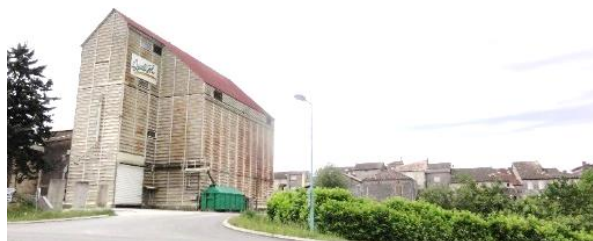
Bâtiment ayant une situation incongrue par rapport à la bastide de Castelsagrat
